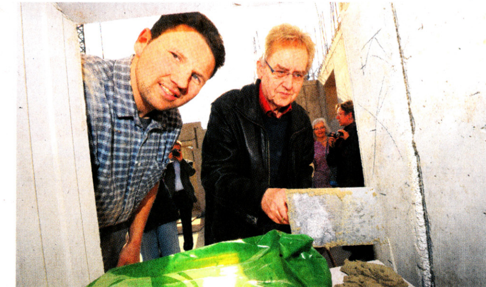
Maurer Michael Grotstabel (l.) erklärt Gerhard Carneim wie der Grundstein des Bauwerks perfekt eingemauert wird.
